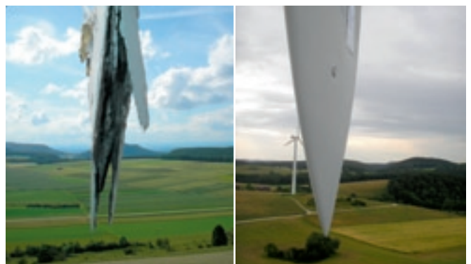
Beschädigte Blattspitze vor der Reparatur (links) und nach der Reparatur (rechts)
