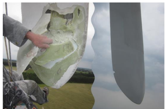
Puntera de pala dañada antes de la reparación (izquierda) después de la reparación (derecha)
