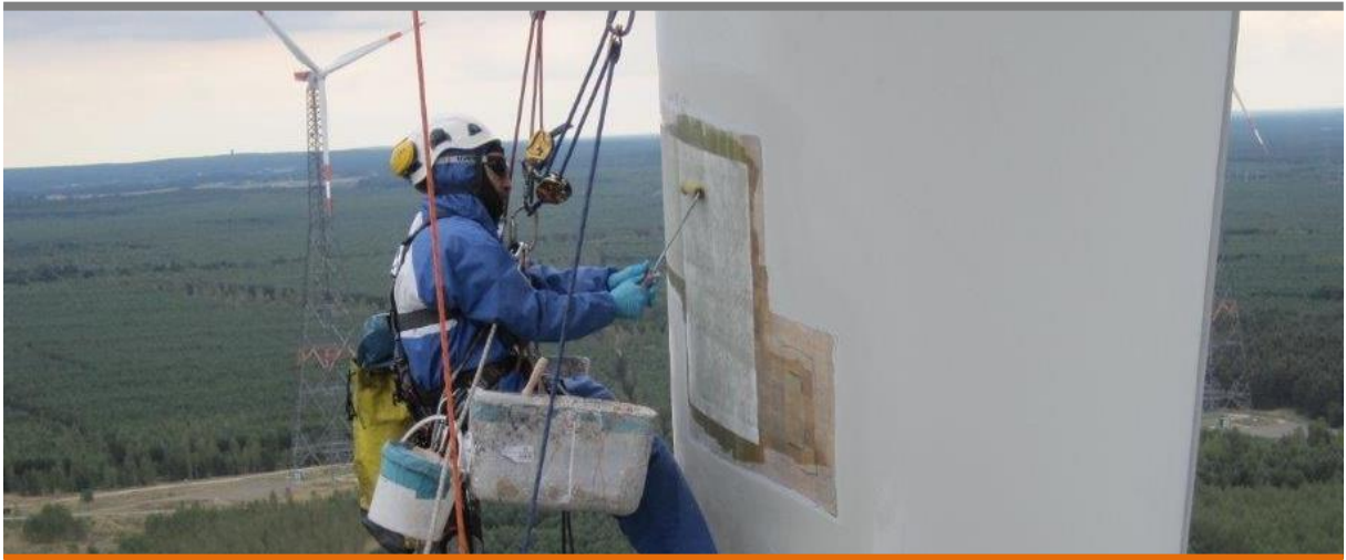
Reparación de palas en campo
